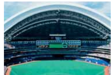
Techo del Skydome en Toronto, Canadá (parábola) Walter Schmid/© Stone/Getty Images
